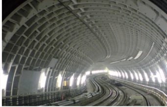
【建設中の山手トンネル】
