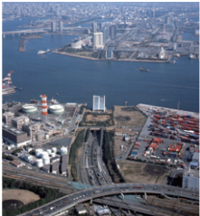
【東京港トンネル】
